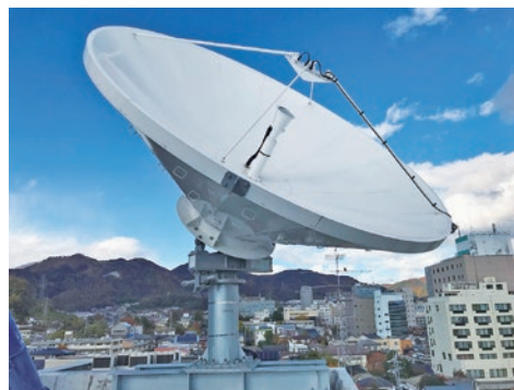
4.5 mφ衛星通信地球局用アンテナ (株長野放送 本社)
